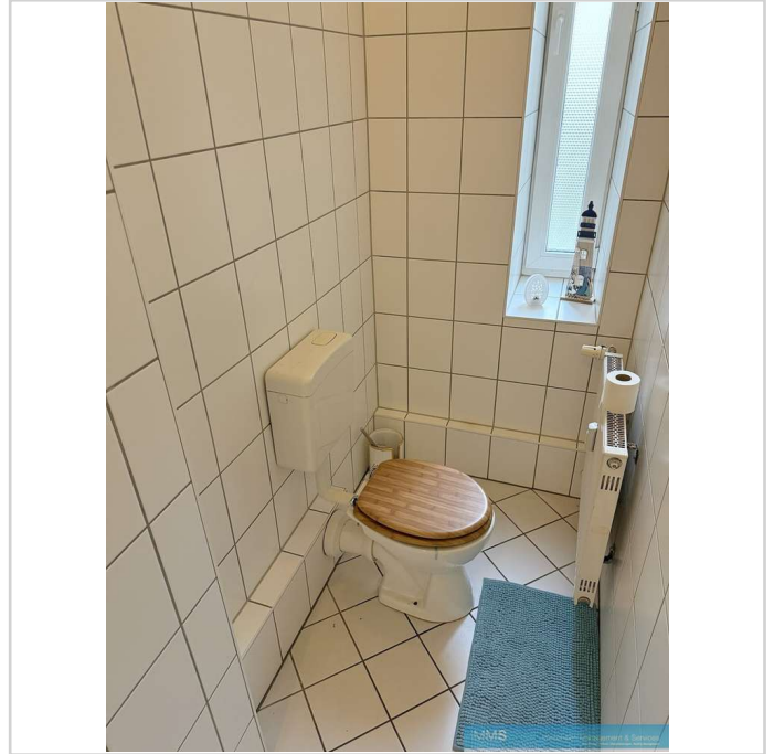
Obj.-Nr. 03250203 - WC Toilett
